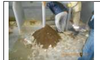
1. Se realizan reparaciones en baños del patio común del modulo 55.
